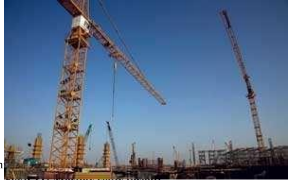
Şekil 11: Masdar şehrin inşaatı
