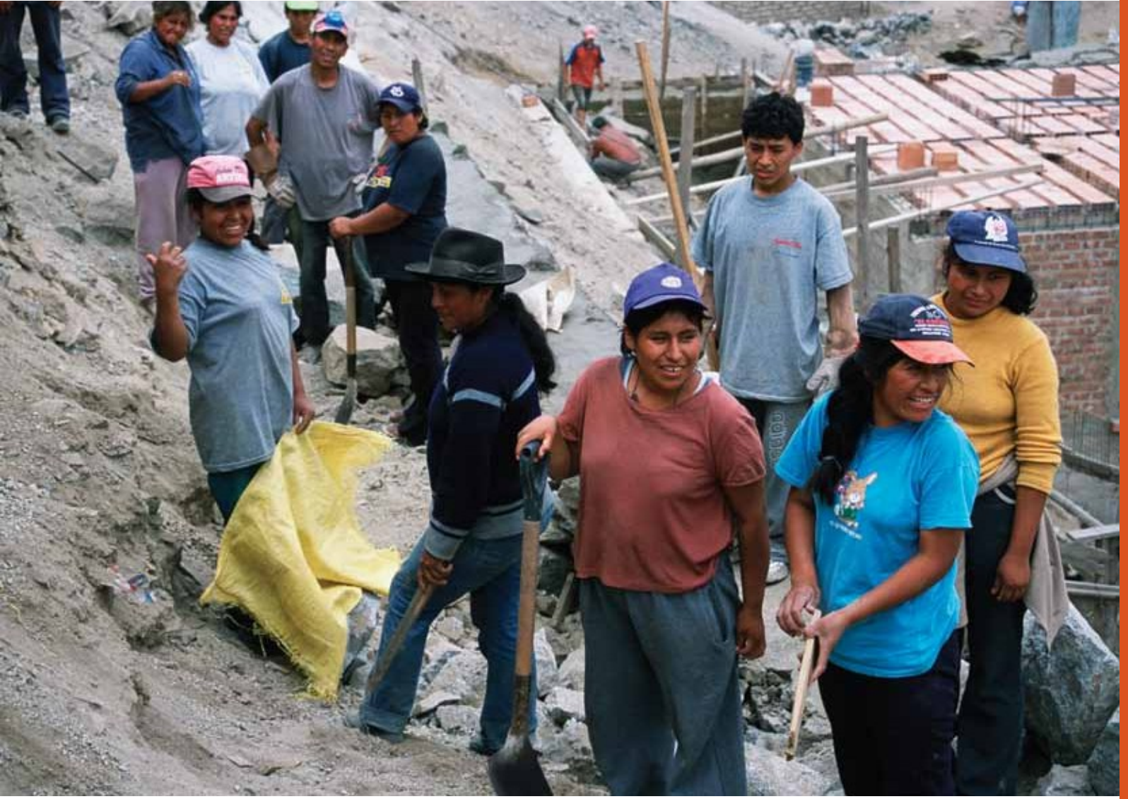
Peru'daki Amauta-B gecekondü mahallesi sakinleri, topluluklarında bir istinat duvarı inşa etmek için çalışıyor.
